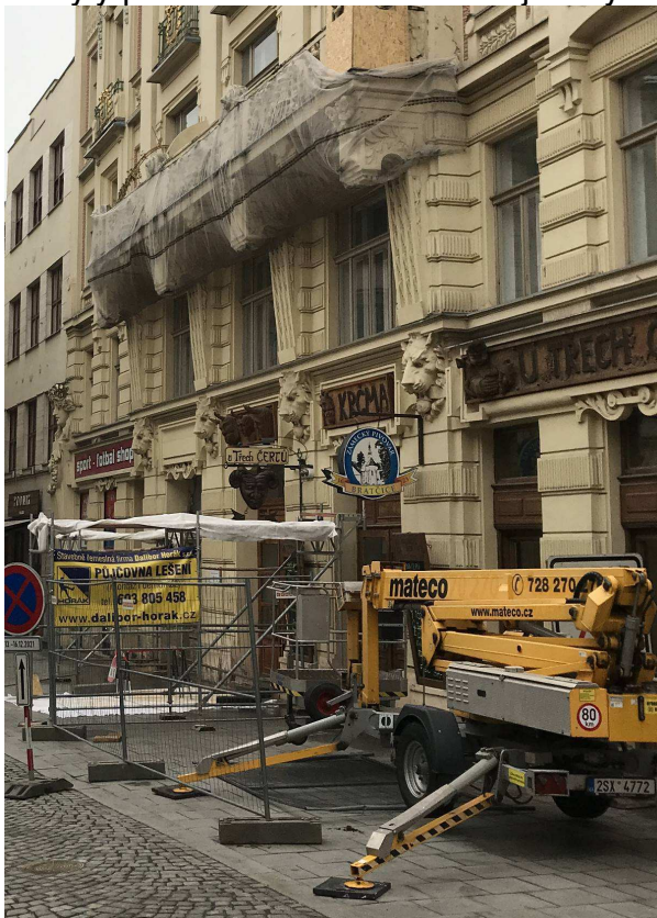
Posílení balkonové desky a vyztužení nosných pilířků BALKONU BYTOVÉHO DOMU STAROBRNĚNSKÁ 7, BRNO
